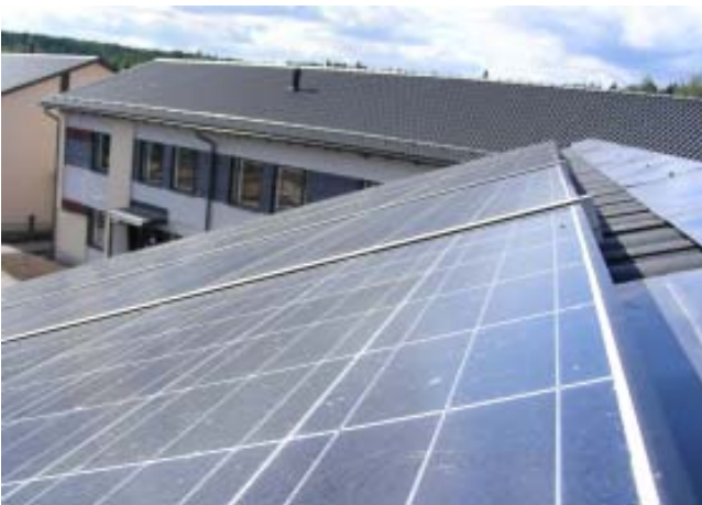
Les toits solaires Naps offrent un moyen fiable et facile de produire de l'électricité à votre domicile. Ci-dessus, un système de 3,0 kWc (kilowatts crête) sur un toit en tuiles.
