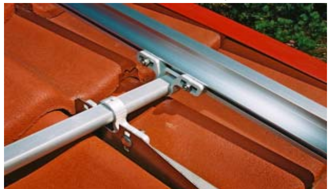
Beispiel eines Spezialhakens für ein Dach mit alten englischen Dachziegeln.
